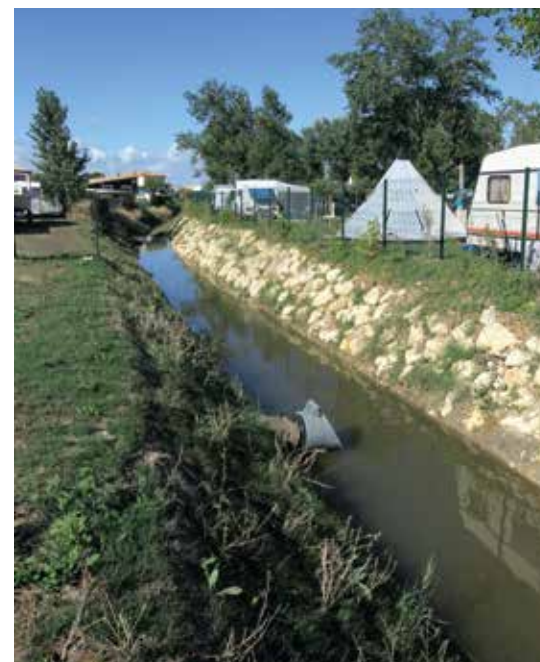
Le Canal de Port Punay aux Boucholeurs, à Yves (travaux réalisés en 2014)
