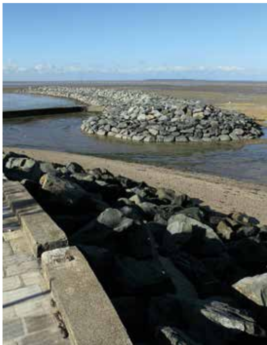
Brise-lame au Nord de Châtelaiillon-Plage (travaux réalisés en 2014)
