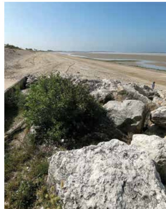
Anse de Godechaud à Aytré (travaux prévus en septembre 2015)
