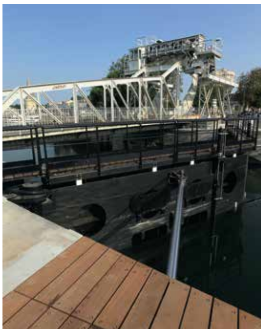
La porte du Bassin des chalutiers à La Rochelle (travaux réalisés en 2014)
