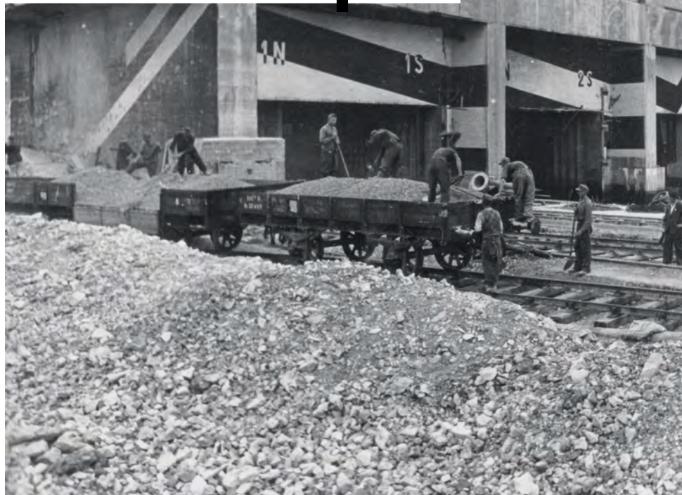
À la Libération, les prisonniers allemands sont employés au déblaiement des gravats de la base sous-marine de La Pallice.
